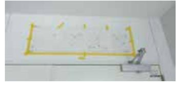
この時に電線位置を壁に印をつけて、壁に電線が通る穴をあけます。
