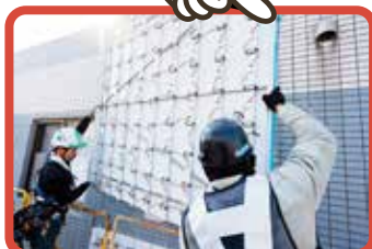
複数のLEDを連結したベースを1枚ずつ設置
