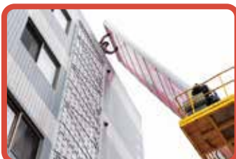
屋上から枠に貼り付けた面版を担ぎ出す
